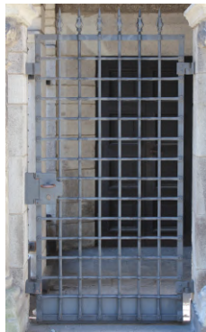
Quadrate: Gittertür auf der Nordseite.
