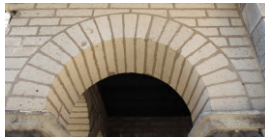
Gleichschenkliges Trapez: Auf der Nordseite über der Gittertür.
