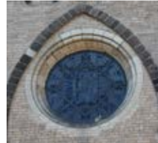
Kreis: Fenster auf der Nordseite.
