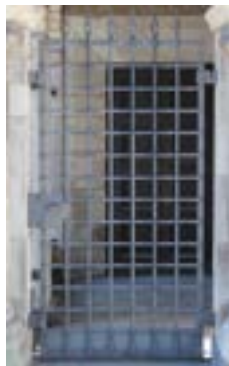
Quadrate: Gittertür auf der Nordseite.
